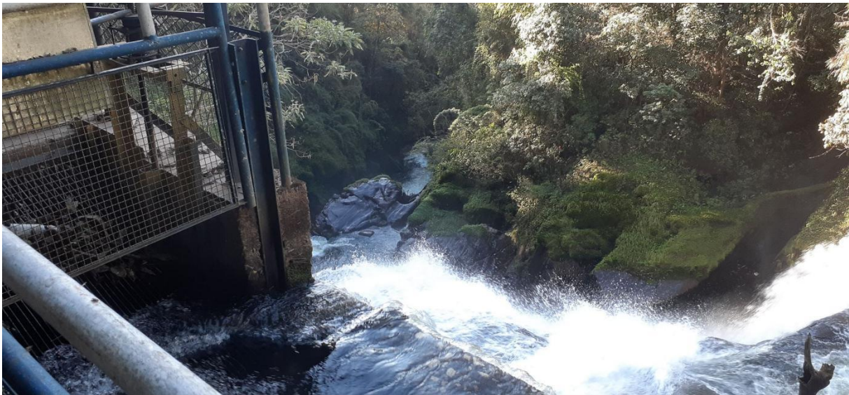
Figura 50: Captação na Mineração Corrêa.
