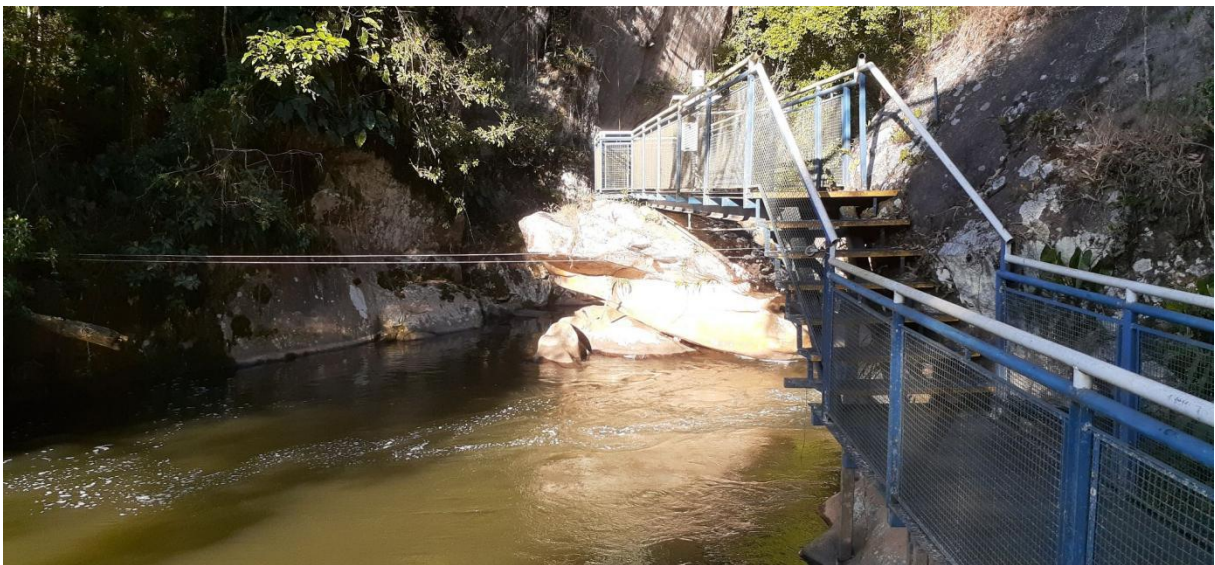
Figura 54: Passarela onde se encontra instalada a estação do CEMADEN.
