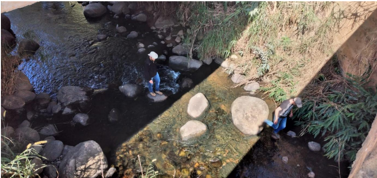
Figura 21: Vista sob a ponte na estrada que dá acesso a Serra do Alambari.
