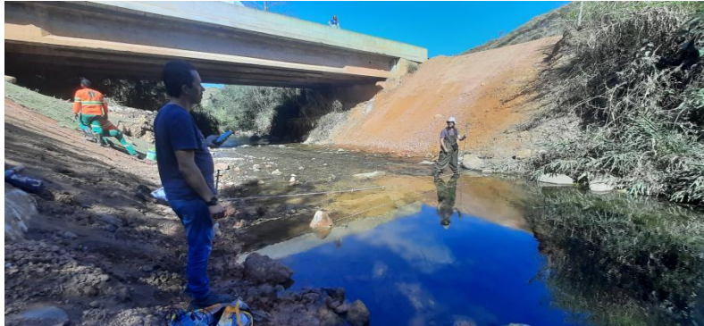
Figura 24: Seção utilizada para a medição de vazões no ponto 3B. Campo 1/6 (julho de 2023)
