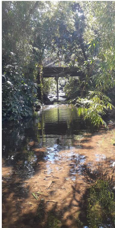
Figura 6: Ponte situada sob o córrego das Couves.
